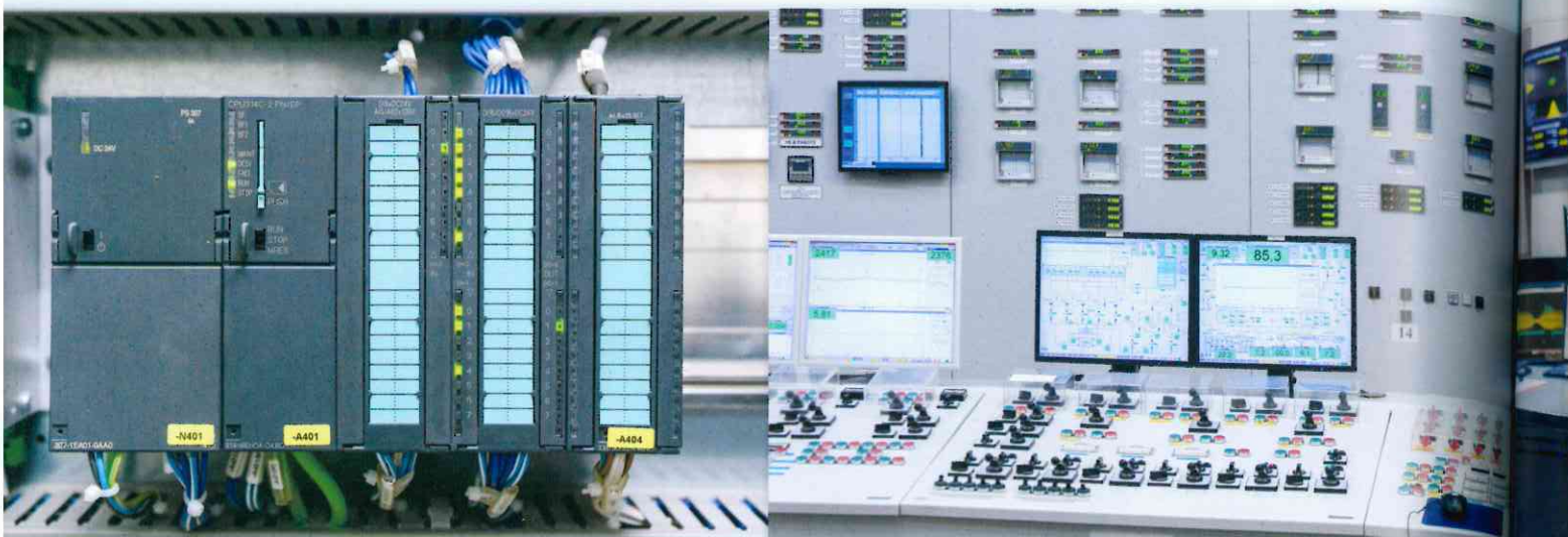
傳統工業控制系統可概分為可編程邏輯控制器（PLC，左圖）、分散式控制系統（DCS，右圖）及 SCADA 等三類。
